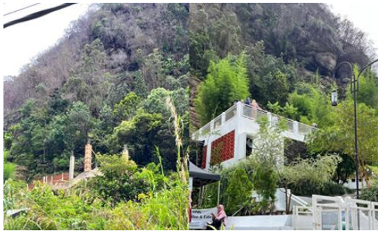
Gambar 3. Pembangunan Kafe dan Homestay di Kaki Tebing Zona Inti Sumber: Dokumentasi peneliti (2026)
